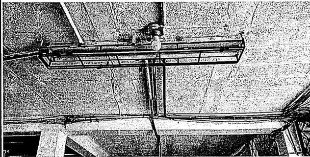
Foto 3: Renovación e instalación eléctrica de cableado nuevo en pasillos
