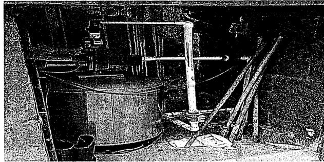
Foto 5: Reemplazo e instalación de nuevo sistema eléctrico y cableado en bombas hidroneumáticas
