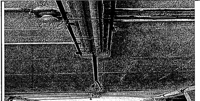
Foto 12: Renovación e instalación de lamparas, cableado para reducir riesgo de corto circuito.
