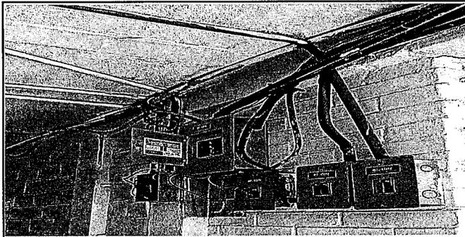
Foto 1: Reemplazo de cajas de tableros y centralizar cargas
