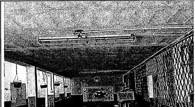
Foto 8: Renovación e instalación eléctrica de cableado nuevo en pasillos Cambio e instalación de tomacorrientes 120 voltios
