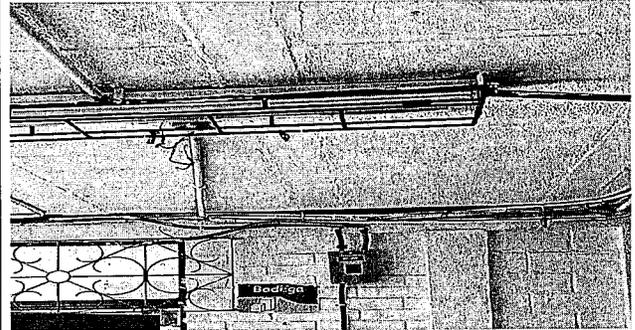
Foto 4: Cambio, instalación eléctrica y cableado de tableros de distribución para centralizar cargas
