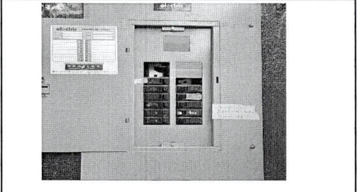
Foto 4: Instalación de tablero y flipones
