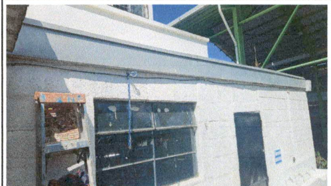
Foto 10: MEJORAMIENTO TECHO EN PATIO CON LAMINA TROQUELADA.
