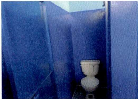
Foto 3: Área donde se realizará Instalación de azulejo en paredes de baños de niñas y niños.
