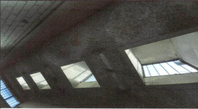
Foto 3: Filtración de agua en la sección de Quinto D Segundo nivel
