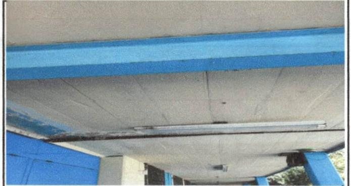
Foto 4: Filtración de agua en el segundo pasillo
