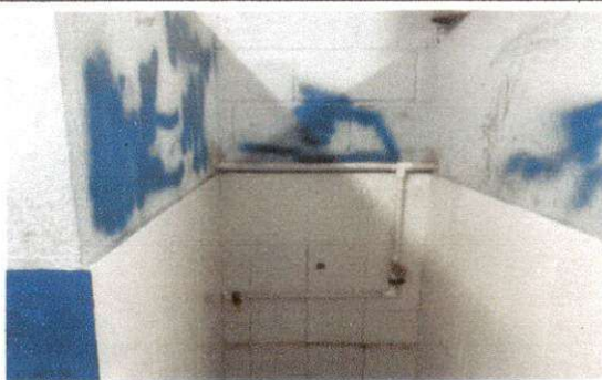
Foto 5: Remodelación de nigetorios primaria varones
