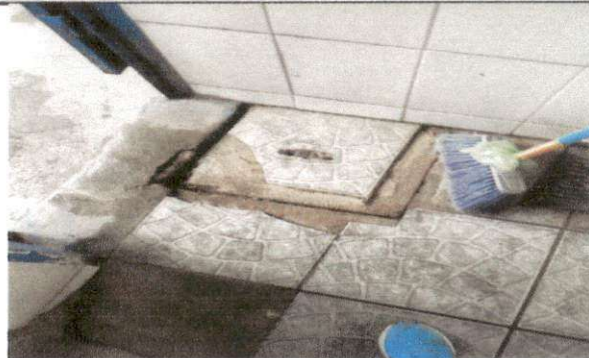
Foto 2: sustitución de piso baño primaria
