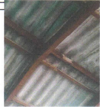
Foto 2: Sustrucción de estructura de soporte de madera por estructura soporte de metal
