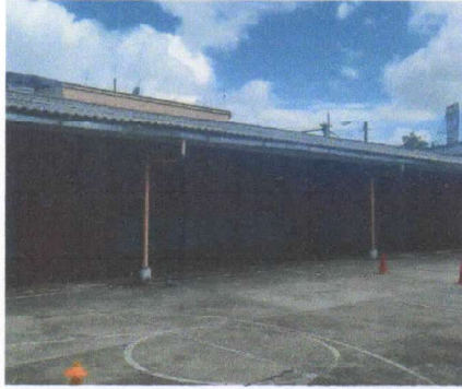
Foto1: Sustrucción lámina troquelada aluzinc calibre 26
