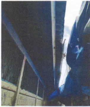
Foto 3: Sustrucción de canales de metal
