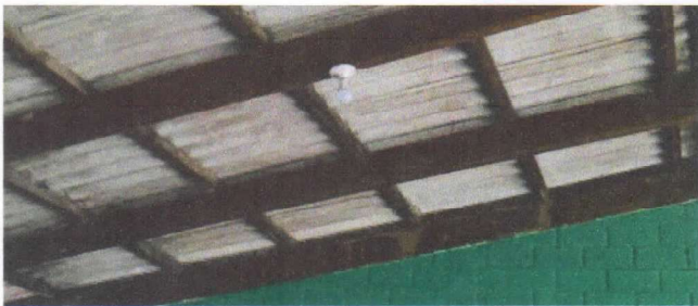
Foto 5: Instalación de unidades luz
