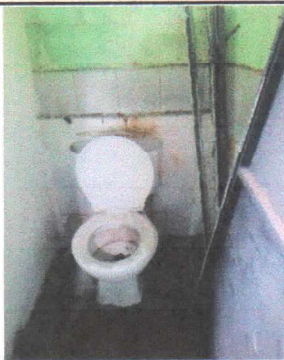
Foto 5: Sustrucción de inodoros
