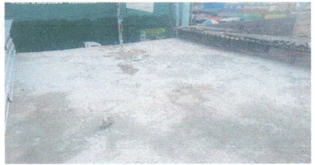
Foto 2: Mejoramiento de losa, con impermeabilizante
