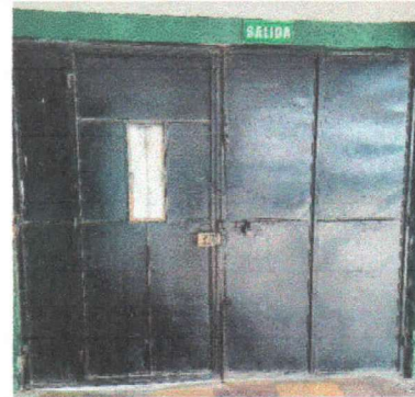
Foto 4: Mantenimiento de portones
