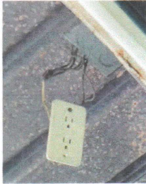
Foto 3: Mejoramiento de sistema electrico en area de baños
