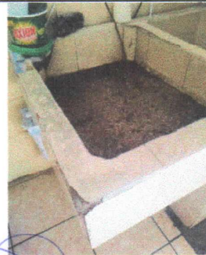
Foto 6: Sustrucción de pila de cemento
