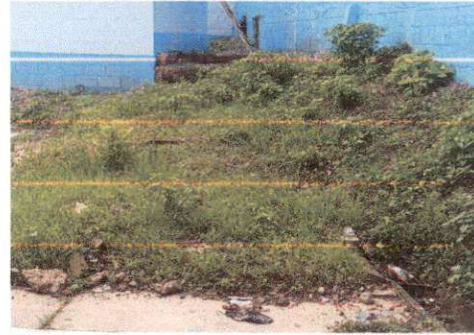
Foto 2: Nivelar y Plancha de cemento (Patio Prepa)
