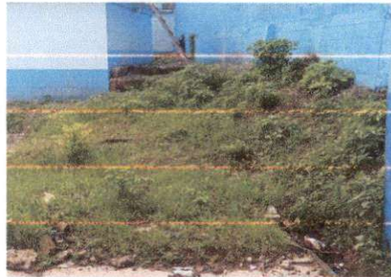
Foto 2: Nivelar y Plancha de cemento
