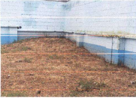
Foto1: Nivelar y plancha de cemento (Patio Prepa)
