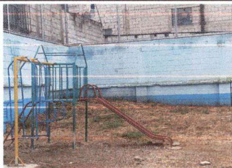
Foto 5: Nivelar y Plancha de cemento (Patio Prepa)
