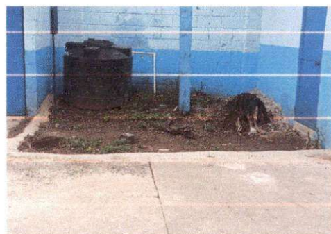
Foto 4: Nivelar y Plancha de cemento
