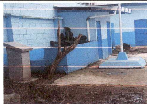
Foto 6: Nivelar y Plancha de cemento
