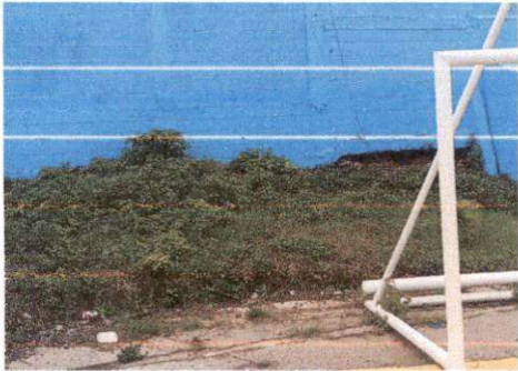
Foto1: Nivelar y Plancha de cemento
