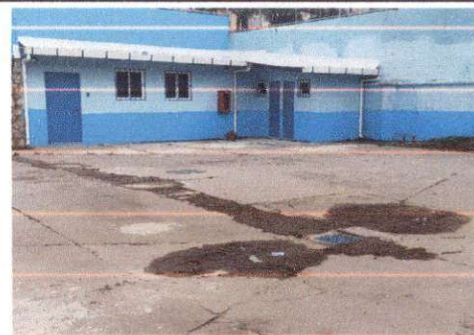
Foto 6: Zanjar metro 1/2 de profundidad en 4 metros de largo, destapar desagüe y rellenar
