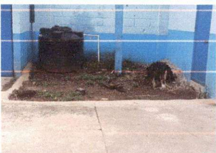
Foto 4: Nivelar y Plancha de cemento
