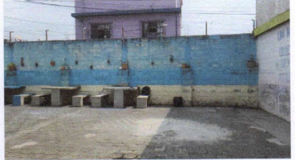
Foto 2: PINTURA ZOCALO Y PERED SUPERIOR LADO INTERNO, LEVANTADO DE BLOCK DE 3 HILADAS SOBRE MURO DE PATIO Y COLOCACIÓN DE ALAMBRE ESPIGADO
