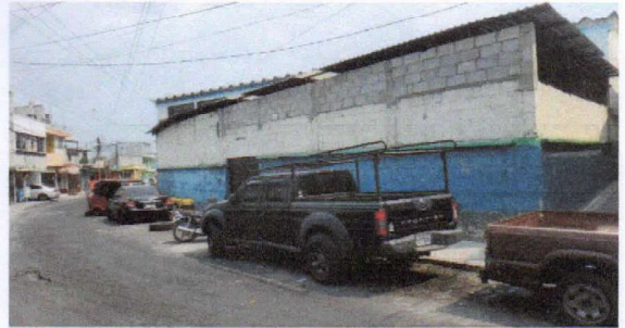
Foto 2: REMOZAMIENTO CON CERNIDO Y PINTURA LADO EXTERIOR SOBRE AVENIDA PRINCIPAL
