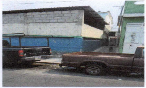
Foto 4: REMOZAMIENTO CON CERNIDO Y PINTURA LADO EXTERIOR SOBRE FACHADA ANEXA A ENTRADA PRINCIPAL
