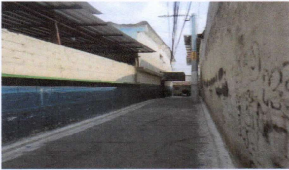
Foto 3: REMOZAMIENTO CON CERNIDO Y PINTURA LADO EXTERIOR SOBRE FACHADA ANEXA A ENTRADA PRINCIPAL
