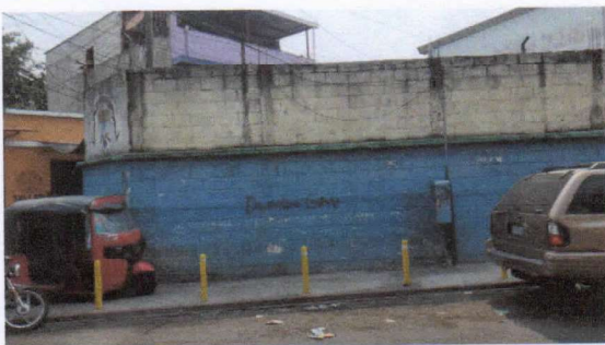
Foto 5: REMOZAMIENTO CON CERNIDO Y PINTURA LADO EXTERIOR DE PATIO.
