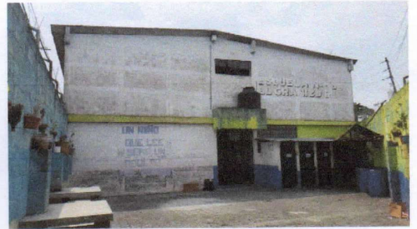
Foto 4: REMOZAMIENTO CON CERNIDO EN PARED FRONTAL Y PINTURA LADO Y EXTERNO
