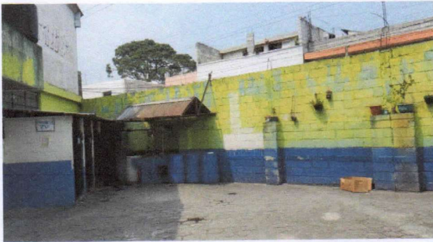
Foto 3: PINTURA ZOCALO Y PERED SUPERIOR LADO INTERNO, LEVANTADO DE BLOCK DE 3 HILADAS SOBRE MURO DE PATIO Y COLOCACIÓN DE ALAMBRE ESPIGADO
