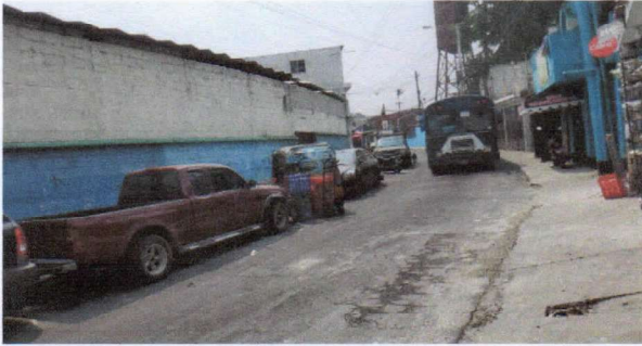
Foto 1: REMOZAMIENTO CON CERNIDO Y PINTURA LADO EXTERIOR SOBRE AVENIDA PRINCIPAL
