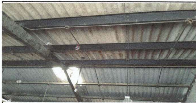
Foto 6: cambio de laminas aula 2
