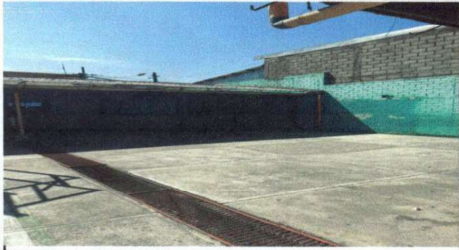
Foto 1: cambio de reposaderas de metal por cemento
