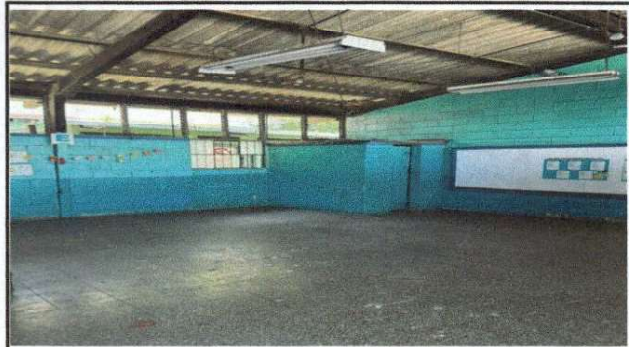
Foto 2: pintura de aulas
