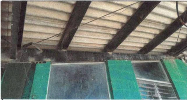
Foto 4: instalacion de energia electrica
