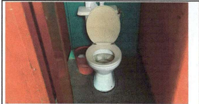
Foto 3: cambio de sanitarios en mal estado
