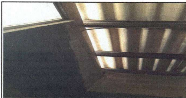
Foto 5: cambio de laminas en mal estado aula 1
