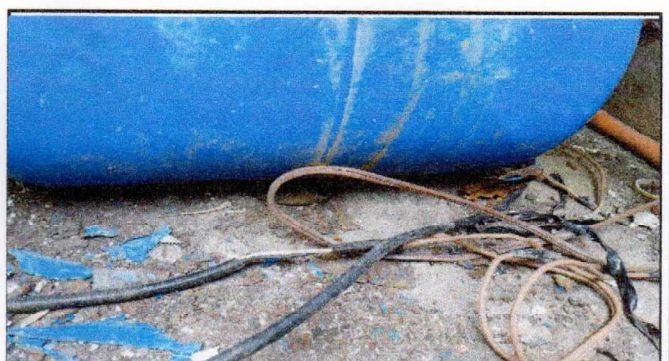
Foto 4: SUSTITUCION DE BOMBA DE AGUA
