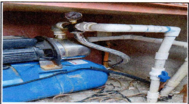
Foto 3: SUSTITUCION DE BOMBA DE AGUA
