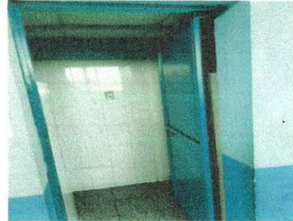
Foto 2: Remodelación de 5 Servicios Sanitarios
