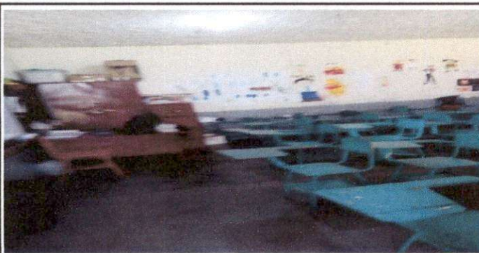
Foto 5: En esta imagen se muestra el piso de torta y pintura deterioradas del aula 5, el cual será sustituido por piso ceramico y pintado nuevamente.
