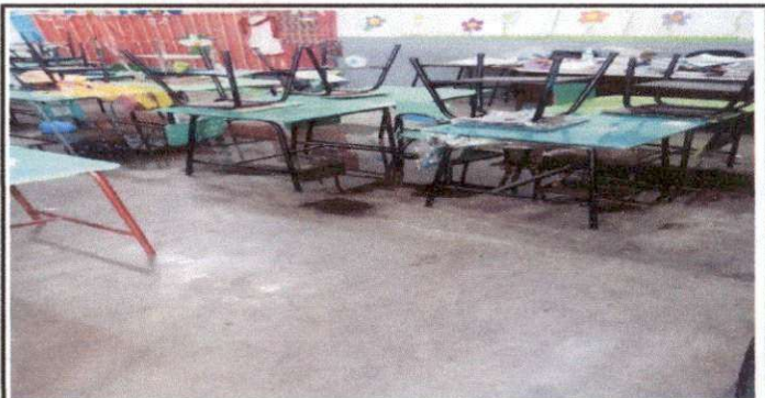
Foto 6: En esta imagen se muestra el piso deteriorado del aula 2 el cual será sustituido por piso ceramico.
