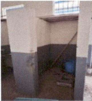
Foto 9: En esta imagen se muestra el espacio vacío de 2 de 4 áreas para sanitarios, en donde se instalaran y habilitaran sanitarios.
