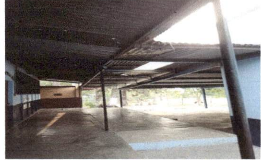
Foto 2: EN ESTA IMAGEN SE MUESTRA LA ESTRUCTURA METALICA CAMBIO DE LAMINA Y MANTENIMIENTO DEL MISMO
