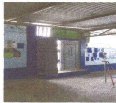
Foto 4: REPARACION PUERTA ENTRADA PRINCIPAL
