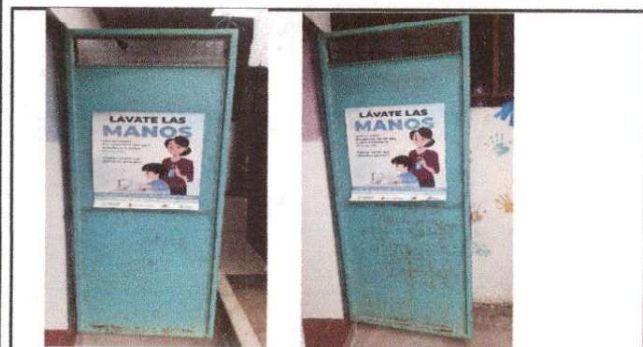
Foto 3: puertas de los servicios sanitarios
