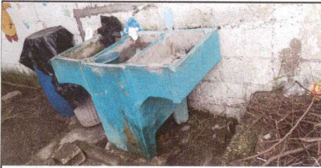
Foto 11: Pila en mal estado y no instalada correctamente
