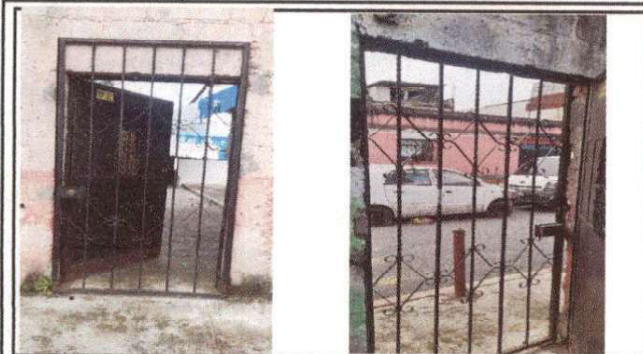
Foto 1: Puerta de reja de ingreso al establecimiento vista desde el exterior
