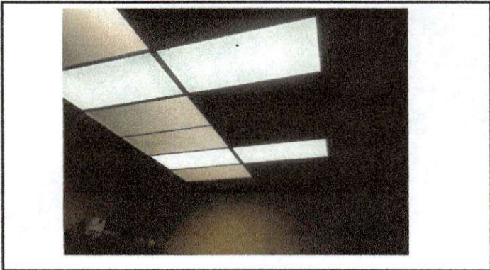
Foto 2: : Cambio de estructura de metal por metal aula número 2 . Cambio de láminas de 26 pies de metal troqueladas calibre 26
