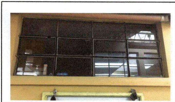
Foto 7 cambio de estructura de ventana de medidad 2.00 por 1.50 en cocina
