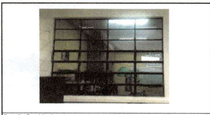
Foto 5: Cambio de estructura de metal de 5 de ventanas 2.30 de ancho X 1.72 de alto
