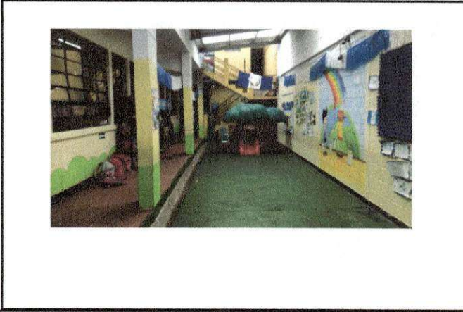
Foto 10: Aplicación de pintura sobre pared interior y exterior del Establecimiento
