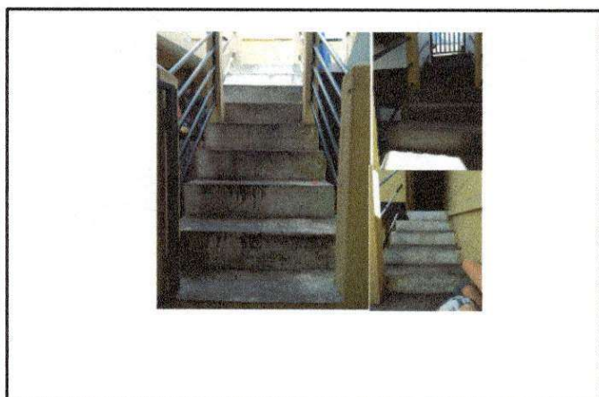
Foto 9: Recubrimiento de piso cerámico sobre escaleras que conducen a terraza y
