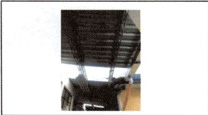
Foto 5: Prte restante del corredor de las cises del cambio de lámina y estructura de las Aulas 1 y 2
