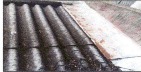
Foto 2: Cambio de lámina duralita por lámina troquelada Aluzinc
