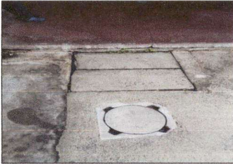
Foto 1: Mantenimiento de cajas de registro por uso y tiempo
