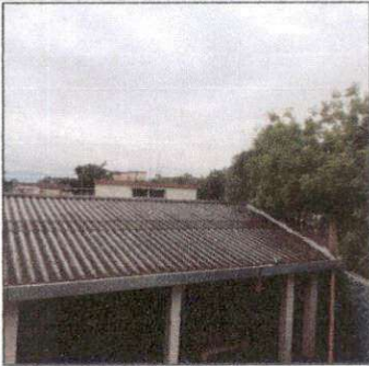
Foto 3: Cambio de techo (láminas)
