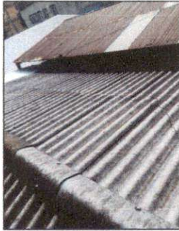
Foto 3: Cambio de techo (láminas)
