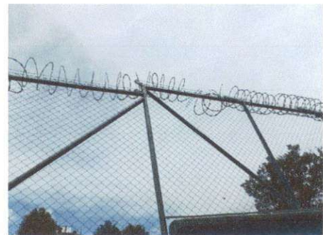
Foto Remozamiento reizon
