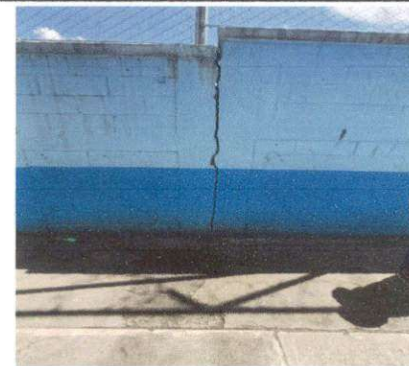
Foto 4: Foto 3: remozamiento union muro
