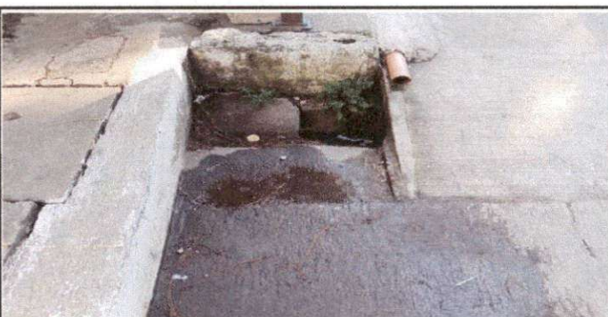
Foto 6: Esta imagen muestra el agujero que se encuentra sobre el patio en el cual se realizara una tapadera de cemento para evitar futuros accidentes
