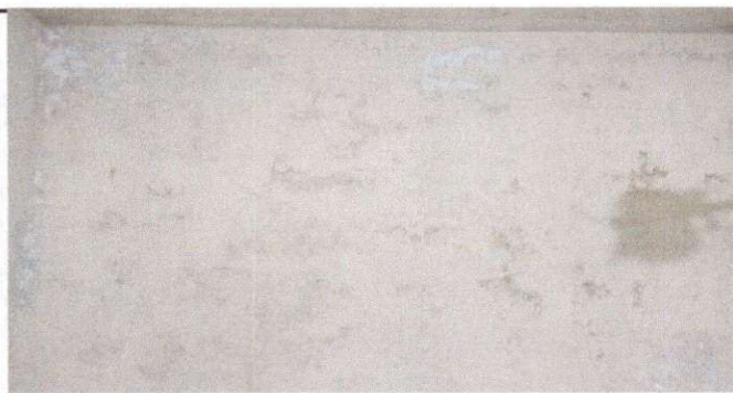
Foto 5: Esta imagen muestra las paredes deterioradas y con hongo las cuales serán repelladas saneadas y pintadas.
