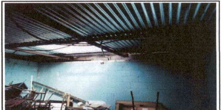
Foto 6: Esta imagen muestra las paredes deterioradas del área de cocina, las cuales serán repelladas y pintadas.
