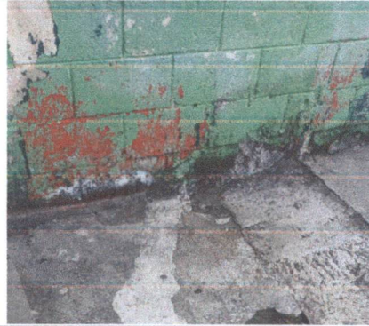
Foto 2: PINTURA EN MUROS
