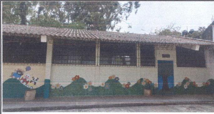
Foto 1: CAMBIO DE TECHO AULA INCLUSIVA
