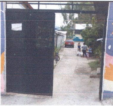
Foto 5: REMOSAMIENTO DE PUERTAS
