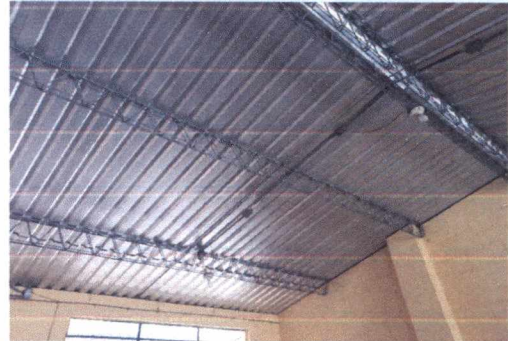
FOTO 2: MANTENIMIENTO A ESTRUCTURA DE SOPORTE DE METAL TIPO JOIST
