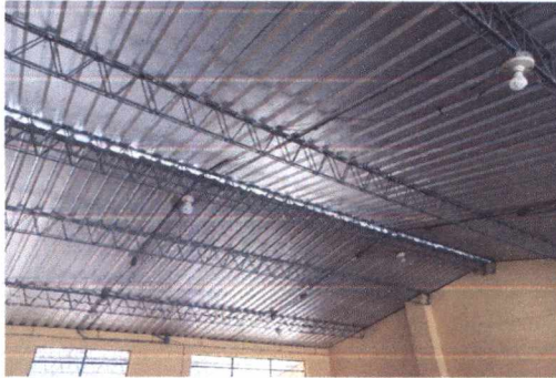
FOTO 1: DESMONTAJE DE LÁMINA DE DURALITA EXISTENTE E INSTALACIÓN DE LÁMINA TROQUELADA CALIBRE 26 EN AULAS
