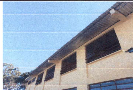
FOTO 6: SUSTITUCIÓN DE LÁMINA DE DURALITA POR LÁMINA TROQUELADA CALIBRE 26 EN PARTE POSTERIOR DE AULAS Y SERVICIOS SANITARIOS
