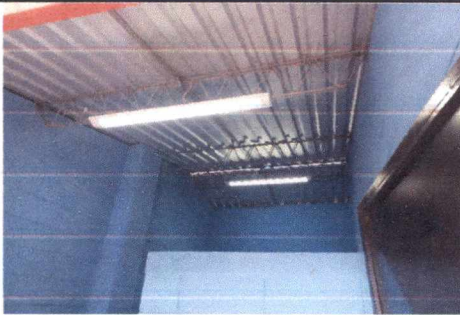
FOTO 5: SUSTITUCIÓN DE LÁMINA DE DURALITA POR LÁMINA TROQUELADA CALIBRE 26 EN SERVICIOS SANITARIOS
