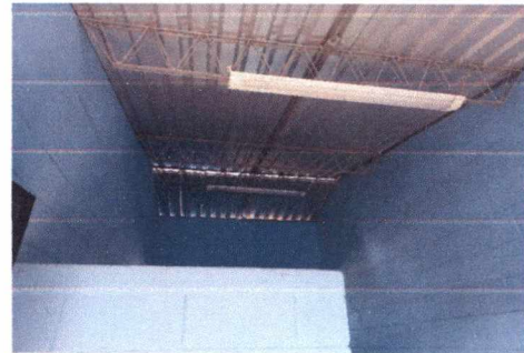
FOTO 4: SUSTITUCIÓN DE LÁMINA DE DURALITA POR LÁMINA TROQUELADA CALIBRE 26 EN SERVICIOS SANITARIOS
