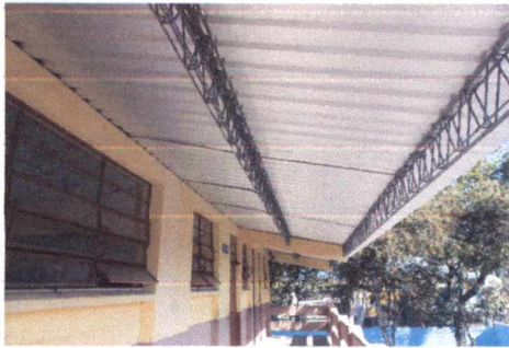
FOTO 3: SUSTITUCIÓN DE LÁMINA DE DURALITA POR LÁMINA TROQUELADA CALIBRE 26 EN CORREDOR
