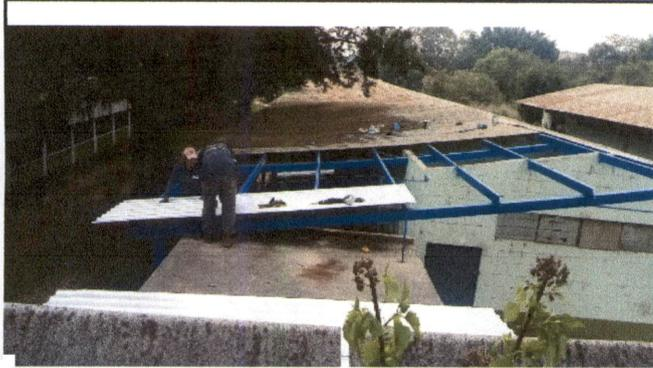
Instalación de Lámina troquelada Aluzinc calibre 26 para aulas de 6to. Perito Contador
