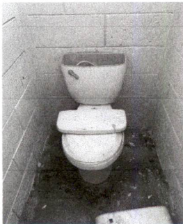
Instalación de inodoros en baños de alumnos hombres y mujeres.
