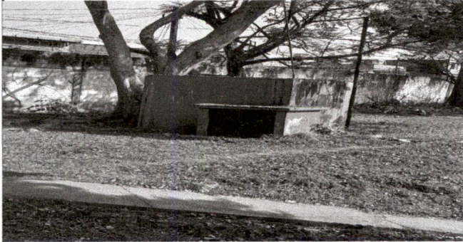
Limpieza y pintura de cisterna
