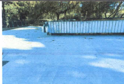
FOTO 6: REPARACIÓN DE PAÑUELOS E IMPERMEABILIZACIÓN DE LOSA
