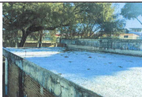
FOTO 4: REPARACIÓN DE PAÑUELOS E IMPERMEABILIZACIÓN DE LOSA
