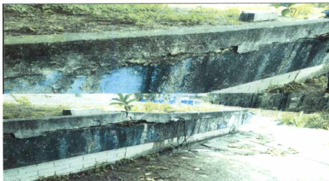
Foto 3: Losa levantandose
