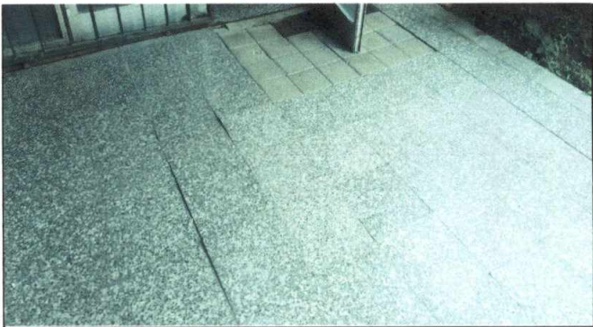
Foto 4: piso afuera de la biblioteca levantado por raíces
