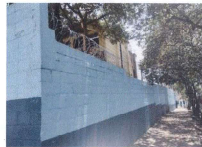
Foto 4: Pintura en muros exteriores (pintura de aceite)
