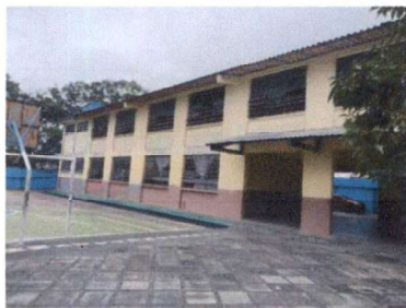
Foto 5: Pintura en muros interior (pintura de agua)
