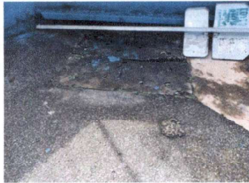
FOTO 7: Sustitución tapadera de caja de recolección de agua
