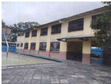
Foto 3: Sustitución de vidrios
