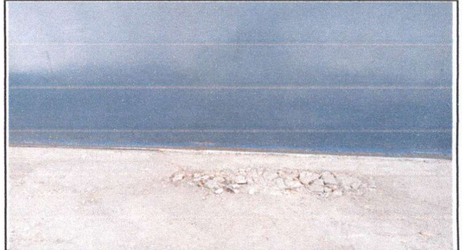
Foto 4: Reparación de grieta en el portón
