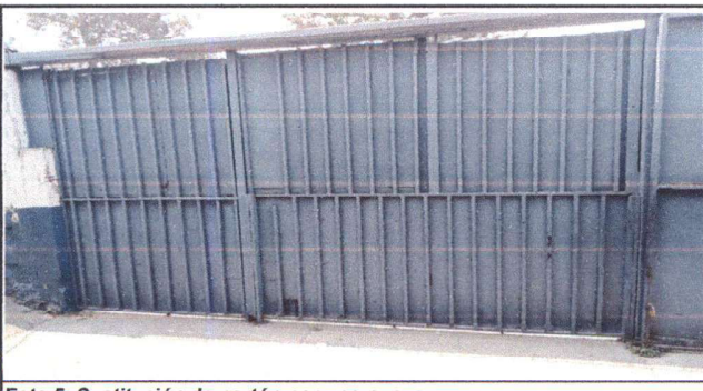
Foto 5: Sustitución de portón por uno nuevo
