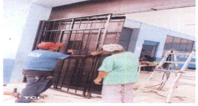
Realización del porto de rejas.
