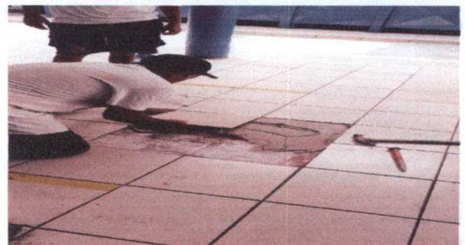
Realización de cambio de piso ceramico.
