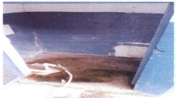
Instalación de bomba.
