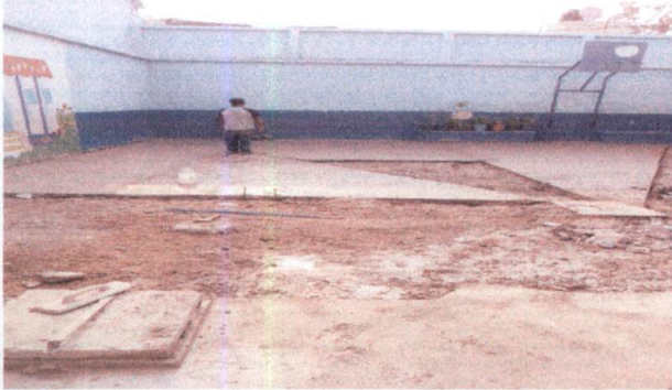
Realización de la torta de cemento patio.
