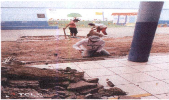
Realización de cambio de tuberías.
