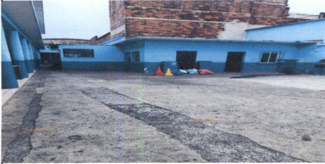
Foto 1:1.1. Sustrucción de piso de torta de concreto por torta de concreto de 10cm de espesor con capacidad de resistencia de 1800 PSI, .
