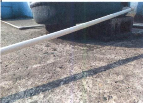
Foto 5: Fabricación de torta de cemento para soporte de depósito de agua de que grosor 10, y en segundo nivel
