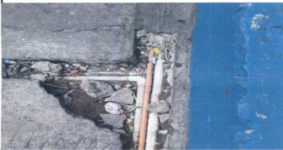
Foto 3: 2.1. Sustrucción de tubería de agua, línea principal de tubo pvc, .
