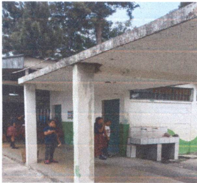
Foto 3: Impermeabilizado de losa Pasillo principal
