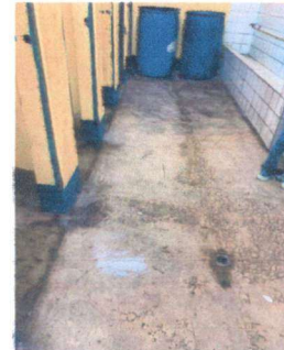
Foto 4: instalación de piso antideslizante en servicio sanitario
