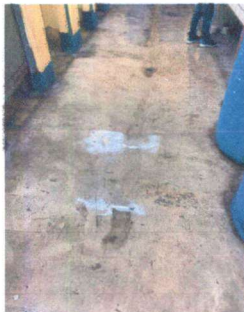
Foto 5: instalación de piso antideslizante en servicio sanitario
