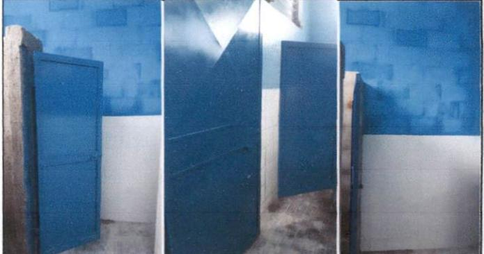
Foto 4: Puertas del baño, Pared nueva e instalacion de azulejo, piso, pintura y repello, cernido
