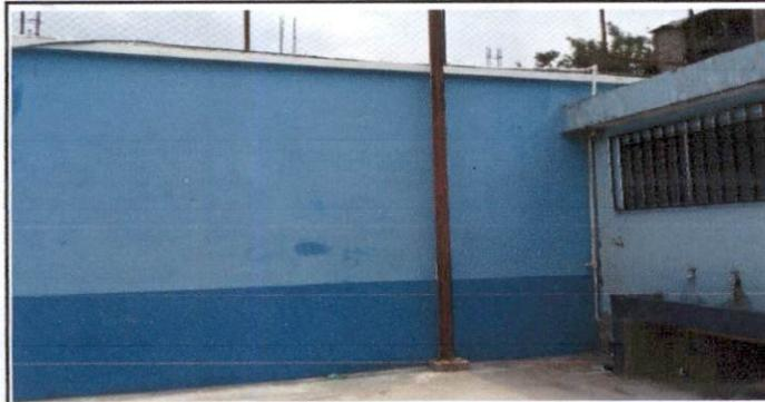
Foto 5: Sustitucion de muro perimetral de adobe por block
