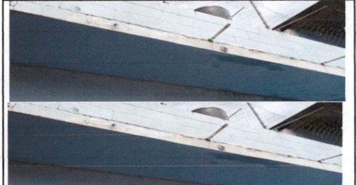
Foto 6: Repello, cernido, impermeabilizacion y pintura corniza
