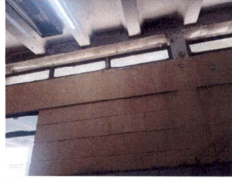
Foto 8: Paredes sanitarios de niños
