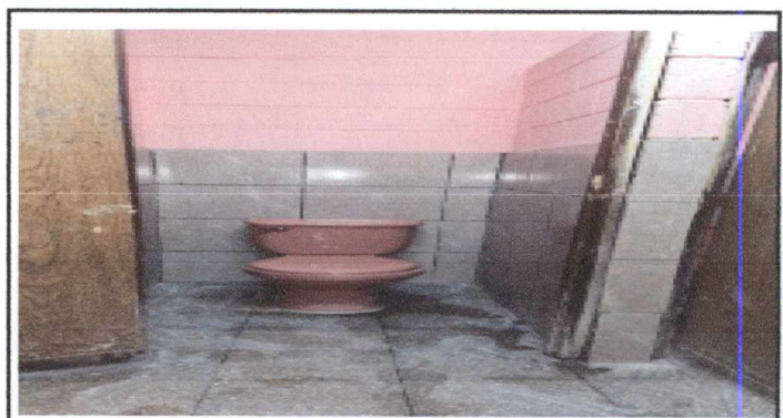
instalacion de sanitarios
