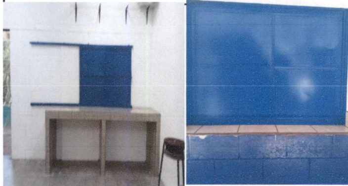
Foto3: acabado final en ventana de cocina
