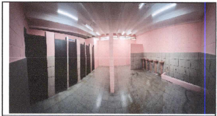
acabado final en area de sanitarios
