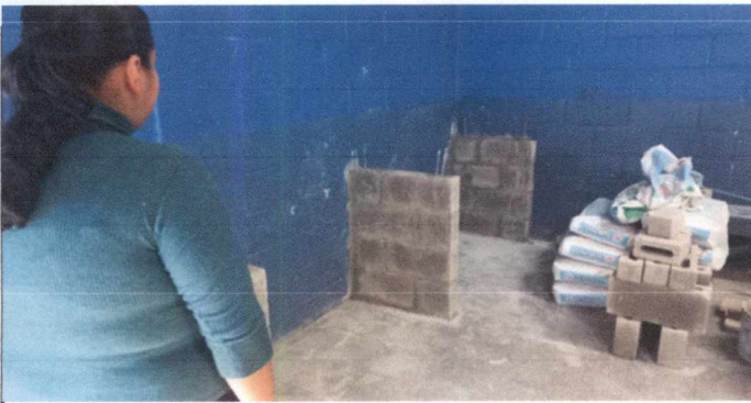
Foto 5: instalacion y suministro de encimera de cocina
