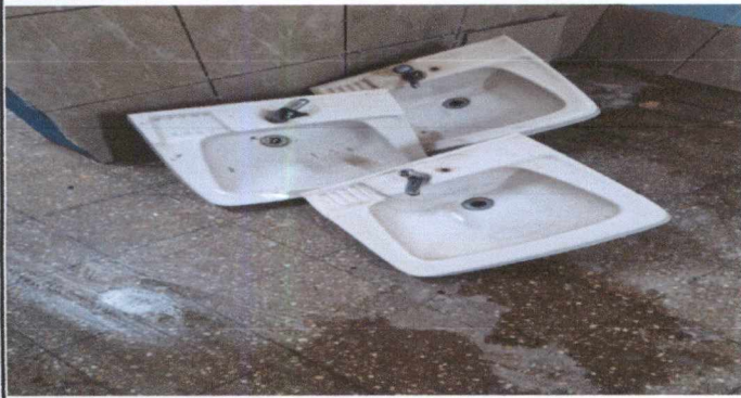
Foto1: demolicion de 5 lavamanos
