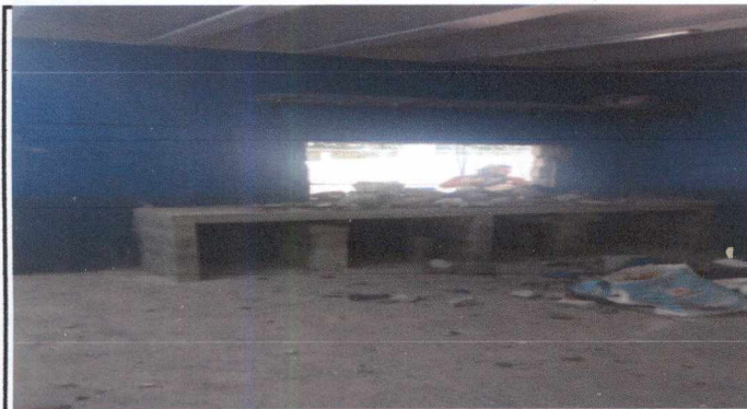
Foto 3: instalacion de la instalacion de ventana
