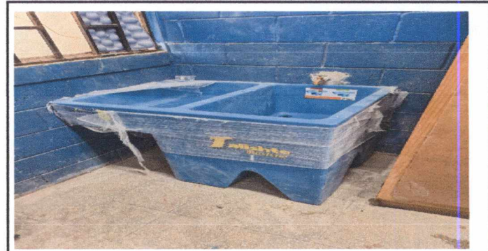
Foto 6: instalacion de la pila
