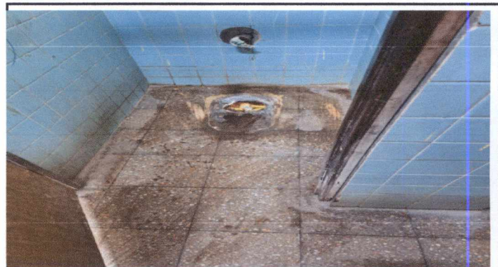
Foto 4: resane antes de la instalacion de sanitarios
