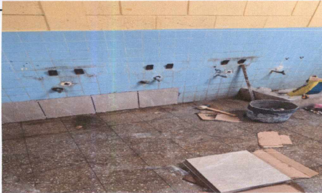
Foto3: instalacion de azulejo en sanitario de Niñas
