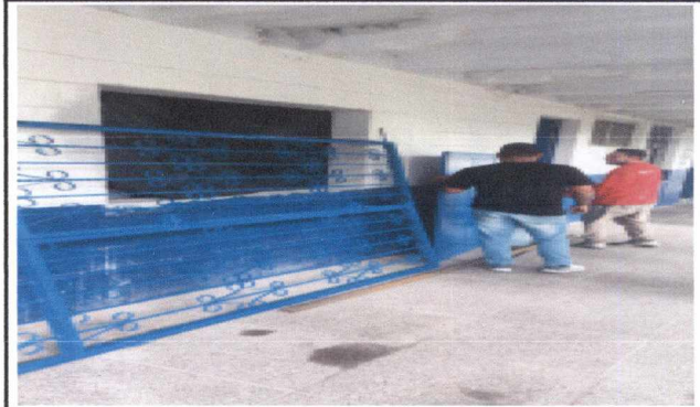
avances en la colocación de la puerta de reja
