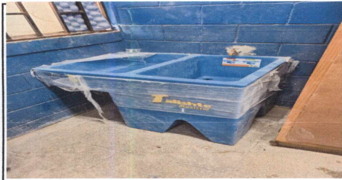
Foto 3: instalacion de pila en area de cocina
