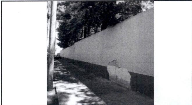
Foto 2: Reparación de 10 mt2 de pintura en pared exterior de toda la escuela, lado de la parte frontal, más repello.
