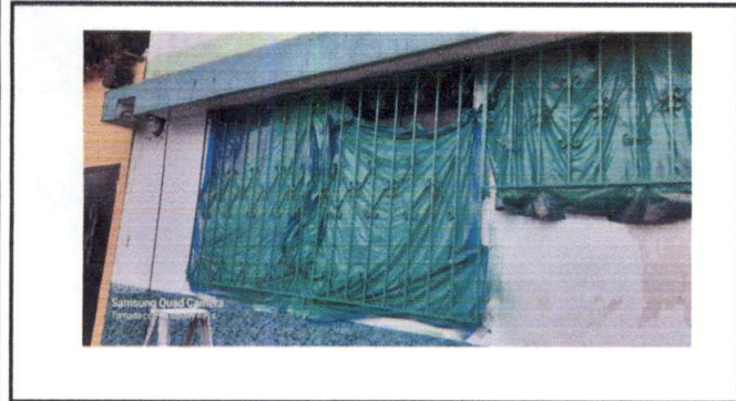
Pintando balcones del lado fuera
