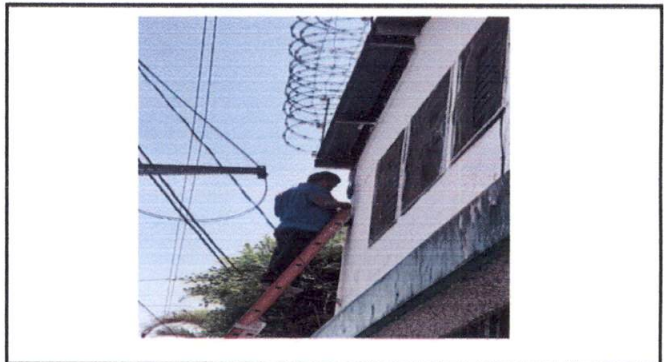
colocando tubo para aguas pluviales
