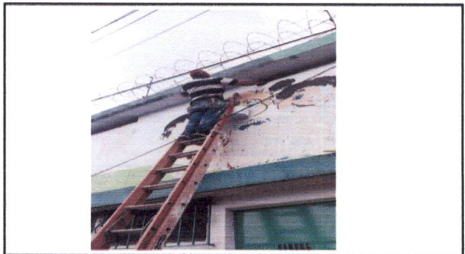
Despintando el exterior del edificio.
