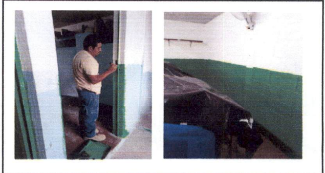
Pintura de segundo color en baños y aulas
