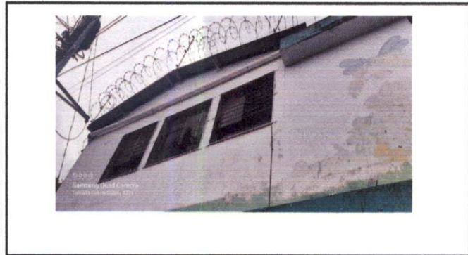
Colocación de tubo de drenaje adicional, en el exterior.
