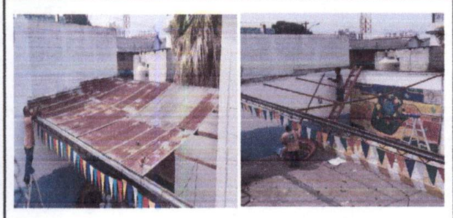
Desmontaje de estructura del techo del patio.
