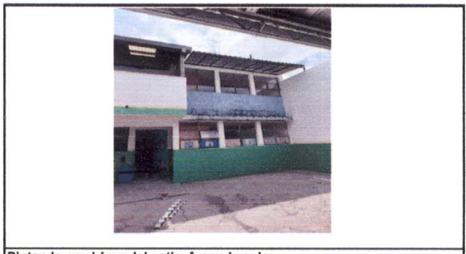
Pintando en el área del patio, fuera de aulas.
