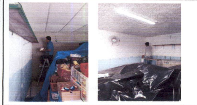
Pintura en aulas. Primer color
