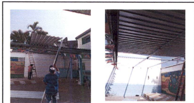
Montaje de estructura de láminas y tubos galvanizados, el techo de patio.
