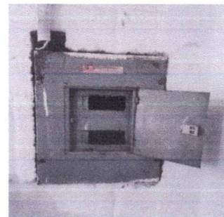
Sustitución de tablero de flipones de 8 a 12 polos
