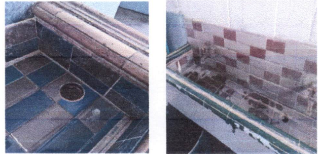
Mantenimiento de lavamanos y sustitución de reposaderas en lavamanos.
