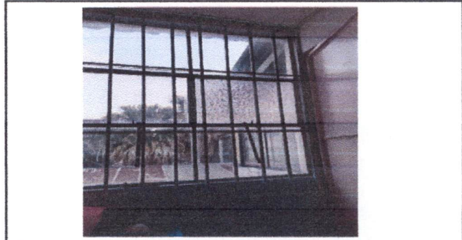
Sustitución de estructura de metal fijo, por estructura corrediza más vidrios.
