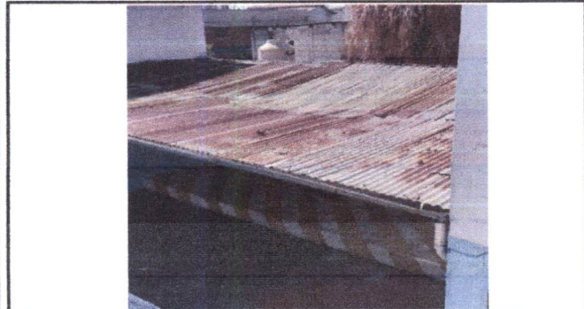
Sustitución de lámina por lámina troquelada calibre 26, en techo del patio, 1er. Nivel
