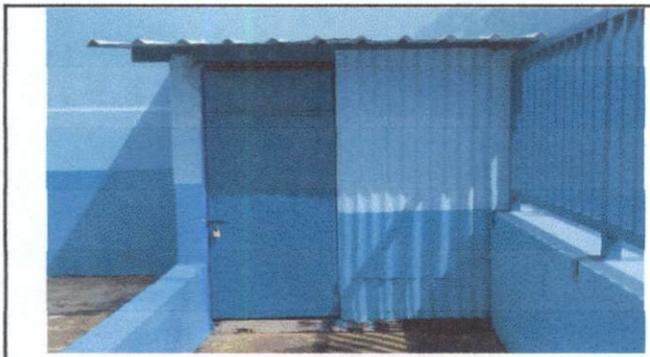
Foto 11: Fabricación e instalación de dos puertas de 0.75 cms de ancho por 1.60 mts de alto para área de bodega de huerto
