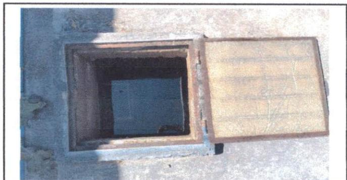
Foto 6: Remozamiento en área de cisterna de concreto, sellando de grietas, cambio de accesorios internos y pintura para piscinas antihongo y antialga
