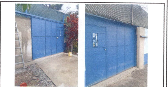
Foto 6: 4.5 Sustitución de portón de metal
