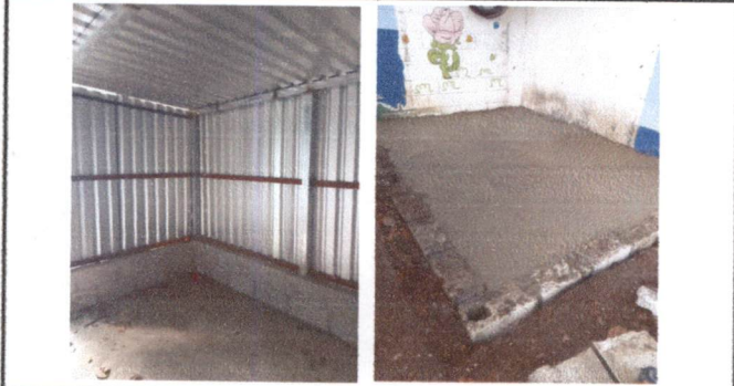
Foto 1: 19.8 Instalación de lámina troquelada de torta de cemento en bodega 6.5 Sustitución de piso
