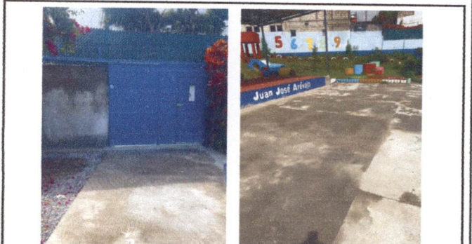
Foto 4: 6.5 Sustitución de piso de torta de cemento ingreso al establecimiento 6.5 Sustitución de piso de torta de cemento en patio
