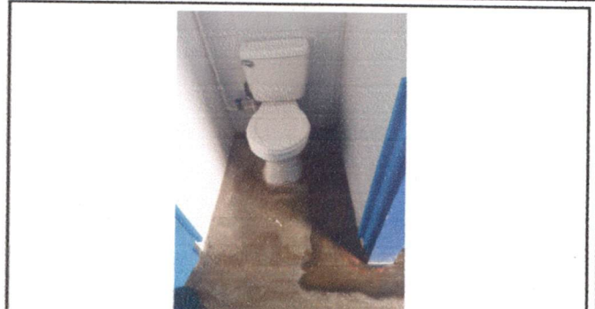
Foto 2: 14.10 Sustitución de llaves de globo, flote y tornillos de inodoros
