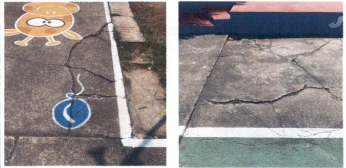
Foto 4: 6.5 Sustitución de piso de torta de cemento ingreso al establecimiento 6.5 Sustitución de piso de torta de cemento en patio
