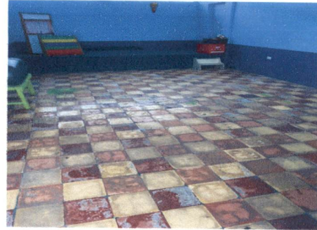
Foto 8: 6.7 Sustitución de piso de granito por cerámico
