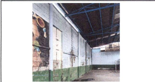
Foto 1: 45 metros de remozamiento a pared por filtración de agua.
