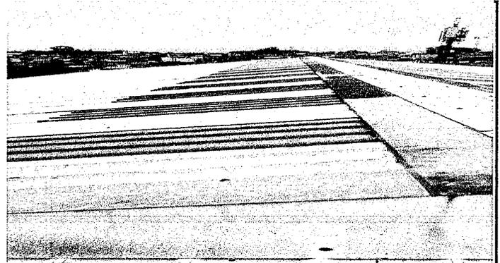
Foto 2: Láminas de policarbonato en mal estado con goteras.
