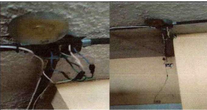
Foto 5: SUSTITUCIÓN DE CABLEADO Y ENTUBADO EN AREAS DE PASILLOS, AULAS Y TALLERES.
