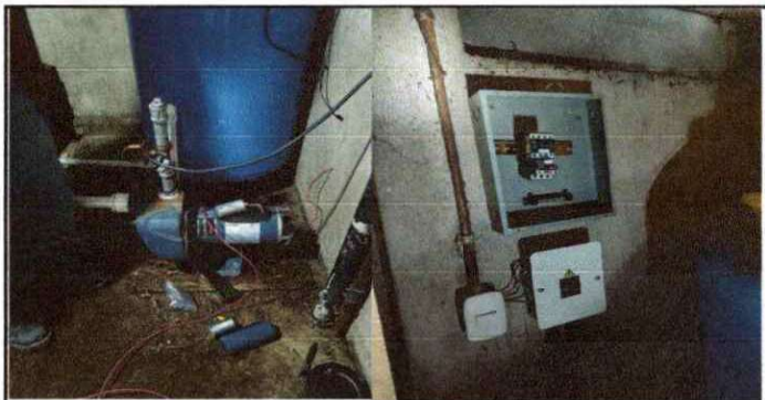
Foto 6: SUSTITUCIÓN DE SISTEMA ELECTRICO UBICADO EN BOMBA DE AGUA
