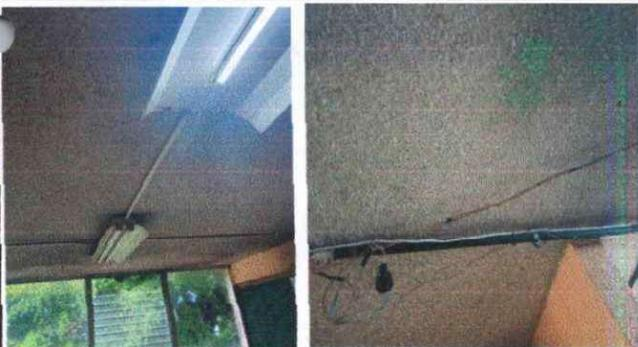
Foto 5: SUSTITUCIÓN DE CABLEADO Y ENTUBADO EN AREAS DE PASILLOS, AULAS Y TALLERES.
