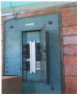
Foto 3: CAMBIO DE TABLEROS ELECTRICOS EN MAL ESTADO POR TABLEROS NUEVOS
