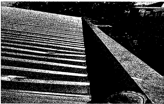
Foto 5: Limpieza de canal, desmontaje de sello viejo en uniones, aplicación de sikaflex, aplicación de fastil elástico, pintado de canal completo.
