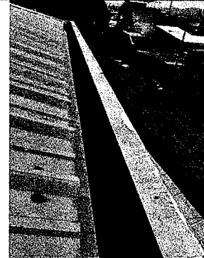
Foto 4: Limpieza de canal, desmontaje de sello viejo en uniones, aplicación de sikaflex, aplicación de fastil elástico, pintado de canal completo.
