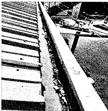
Foto 3: Limpieza de canal, desmontaje de sello viejo en uniones, aplicación de sikaflex, aplicación de fastil elástico, pintado de canal completo.
