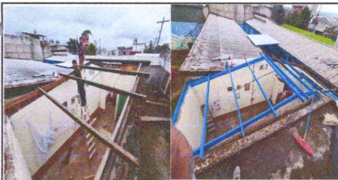
Foto 5: SUSTITUCIÓN DE LAMINA POR LAMINA ALIZINC CALIBRE 26 EN GUARDIANIA YA QUE ESTA EN MAL ESTADO, PICADA Y MANTENIMIENTO A ESTRUCTURA DE LAMINA.
