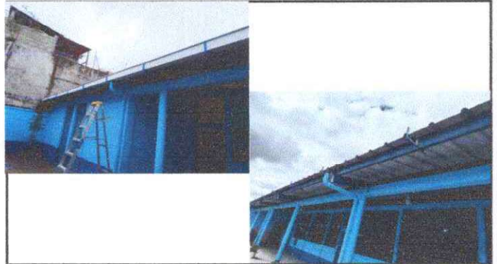
Foto 2: SUSTITUCIÓN Y REPARACIÓN DE CAIDAS DE AGUA PLUVIAL , SUSTITUCIÓN DE SOPORTES DE METAL PARA CANAL.
