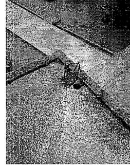
Foto 2: Mantenimiento caída de agua terraza de cocina, sustitución del tubo de caída
